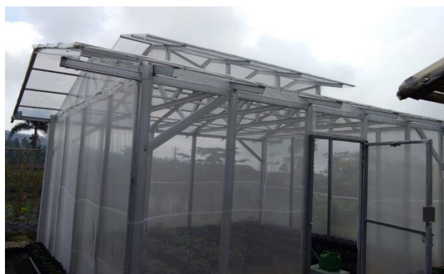
Gambar 2. Konstruksi screen-house yang dibangun pada lahan Mitra.
