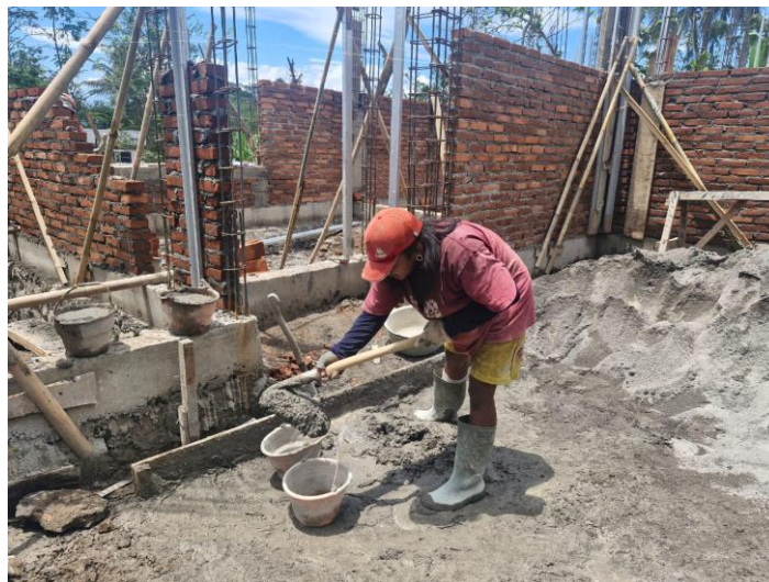
Gambar 2 Pekerja konstruksi pada pekerjaan dinding
